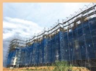
全區主結構已完成
